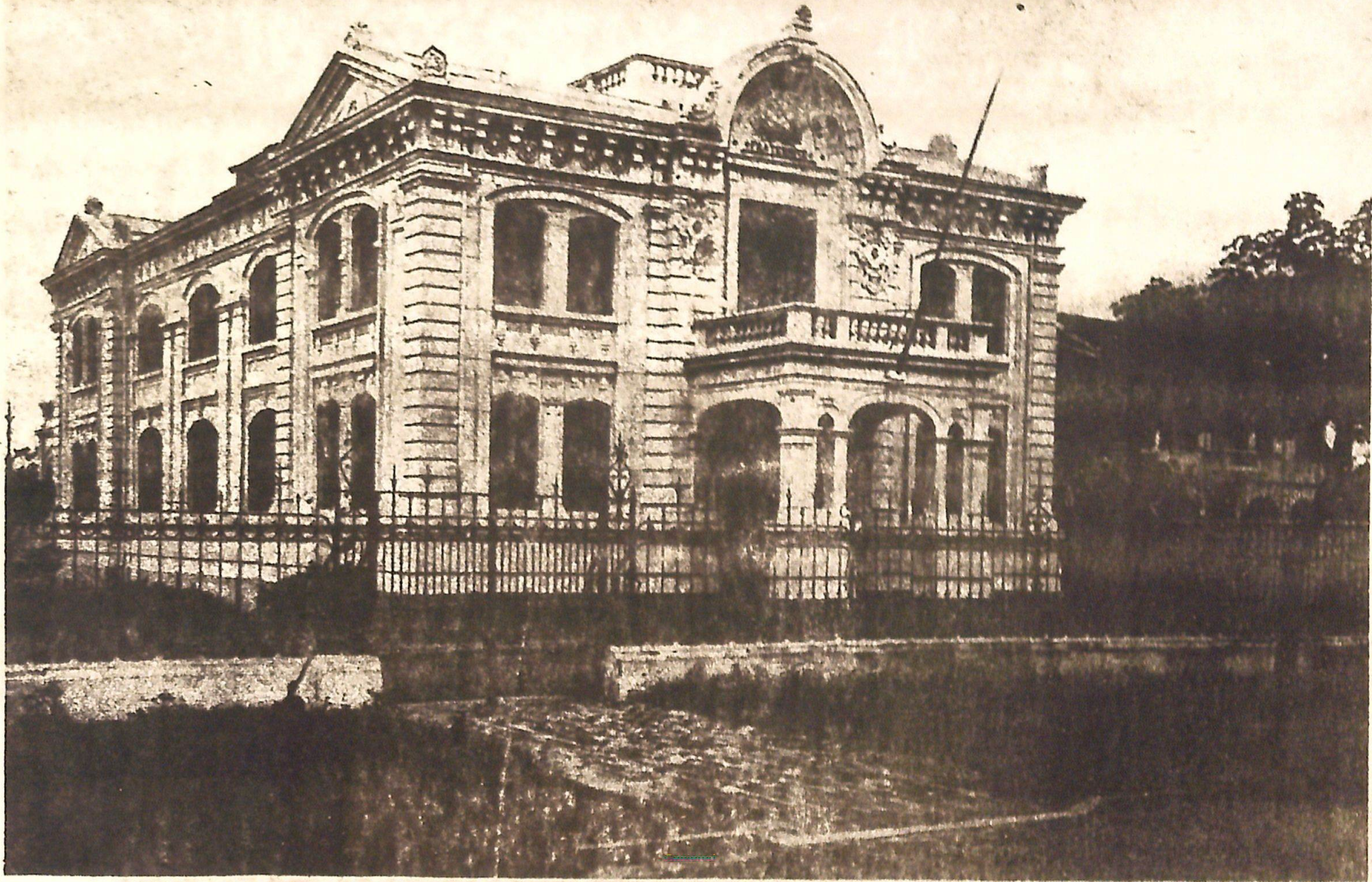
3003. TONKIN — Hanoï - Loge Maçonnique
